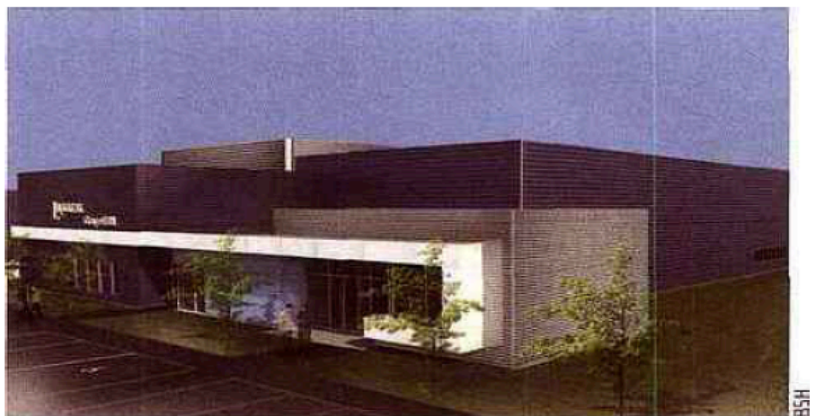
Les nouveaux locaux de 2 400 m 2 accueilleront, en 2012, l'unité de production pour le médical, Luponax biomédical.
